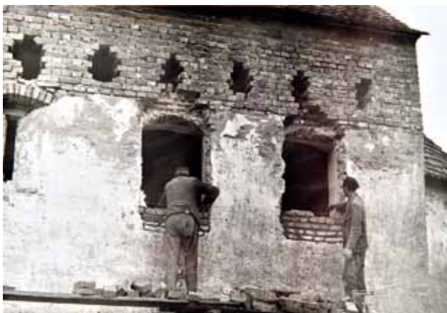
33 Obnova crkve sv. Martina u Lovčiću 1968./69. – rekonstrukcija romaničkih prozora na južnom zidu crkvenoga broda (foto: B. Kralik, fototeka MK AKOSB)
